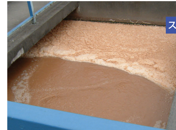
アンバルカー HO 投入前
