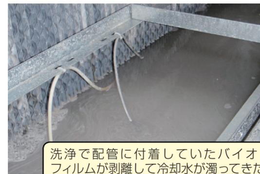
洗浄で配管に付着していたバイオフィルムが剥離して冷却水が濁ってきた
