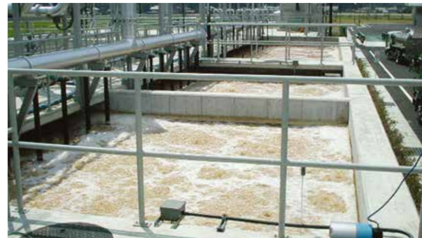
流動床式排水処理設備 バイオネスト 曝気槽内で微生物を付着させた担体を常時流動させ、浄化効率を上げるシステムです。標準活性汚泥法に比べ多様な有用微生物を出現させる省スペース・省コスト・省力の処理システムです。
